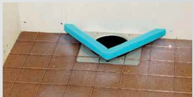
Vid flytspackling används spärrlist.
