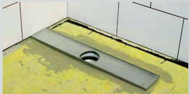
Vid platsättning monterar rännans ram. Säkerställ att den monterar plant och i rätt höjd i förhållande till det färdiga golvet. Var noga med att långsidan monterar parallellt med närmaste vägg.
