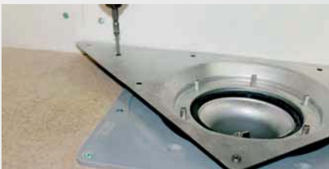
Vid väggnära montage i träbjälklag används BLÜCHERs montageplatta, RSK 712 95 28.
